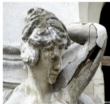
Разрушение скульптуры под действием кислотных дождей
