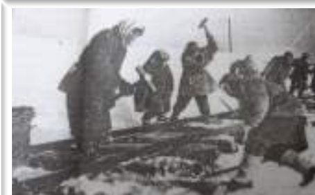
На строительстве железной дороги Кизляр – Астрахань
