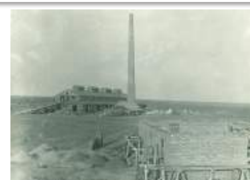
Общий вид строительства кирпичного завода в г. Элисте, 1931 г.
