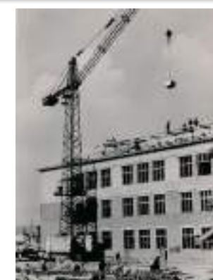
Строительство новой школы в Элисте
